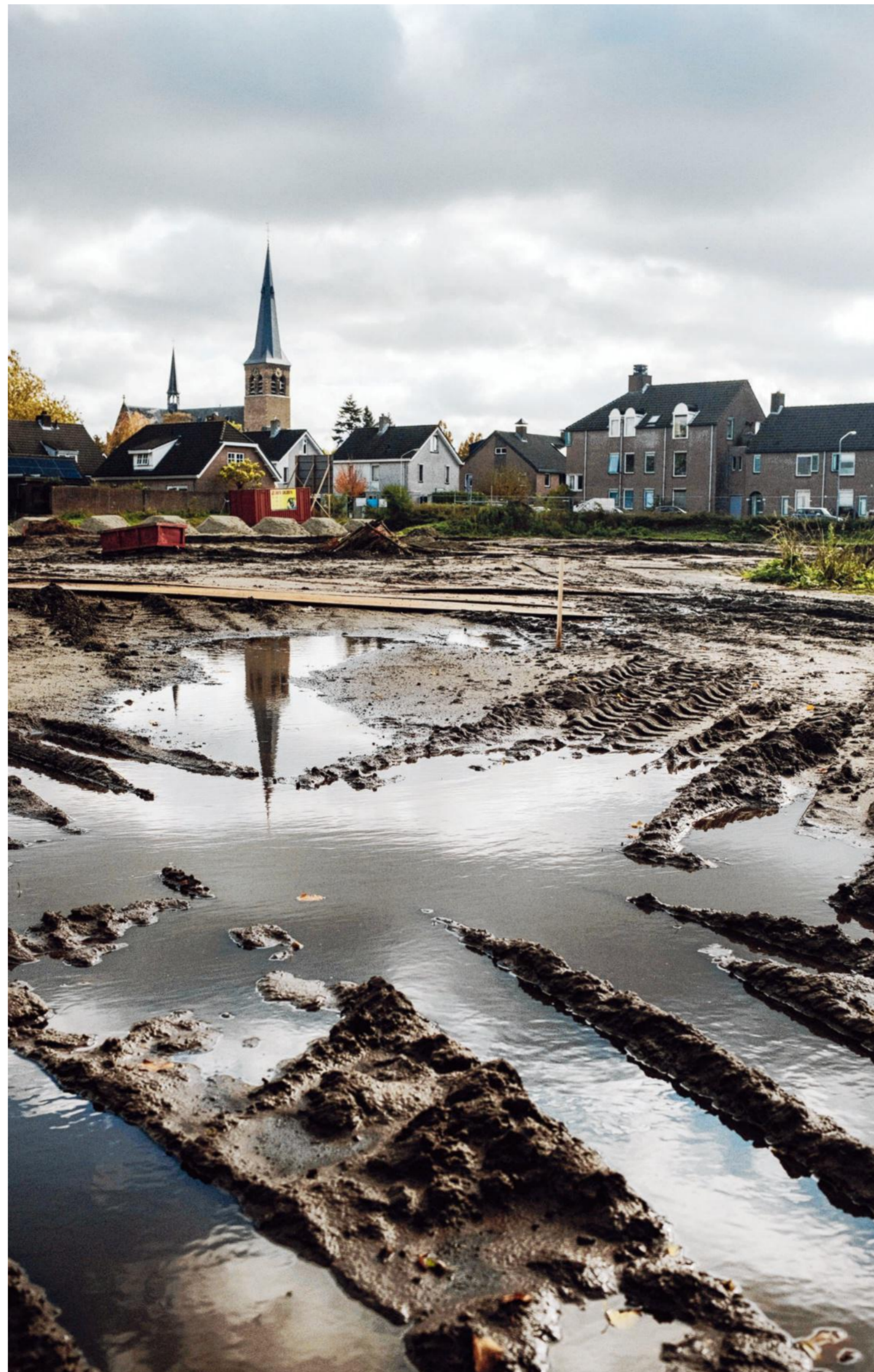
De werkzaamheden in Terheijden lopen vertraging op.
