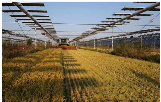
*Bild 40: Hoch aufgeständerte Anlagen mit schmalen PV-Modulen. © REM Tec*
