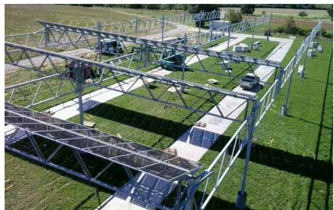
Bild 49: Baustraßen zur Vermeidung von Bodenverdichtung.
