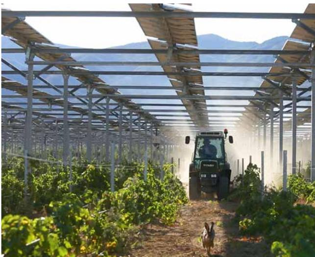
Bild 41: Hoch aufgeständerte Anlage mit durchgängigen Modulreihen. © Sun'Agri
