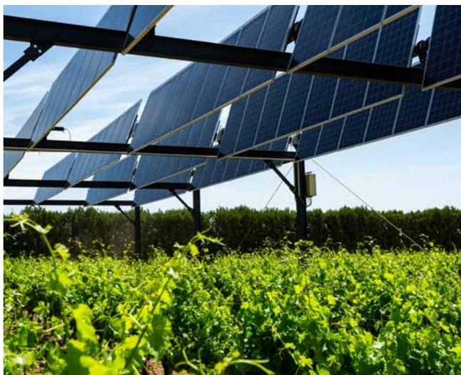
Bild 42: Einachsiges Trackersystem einer Demonstrationsanlage in Frankreich. © Sun'Agri
