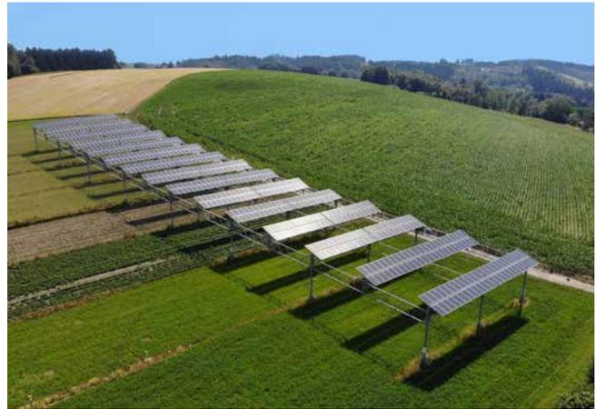
Bild 47: Agri-PV-Anlage in Heggelbach mit einer Leistung von 194 kW<sub>p</sub>. © BayWa r.e.
