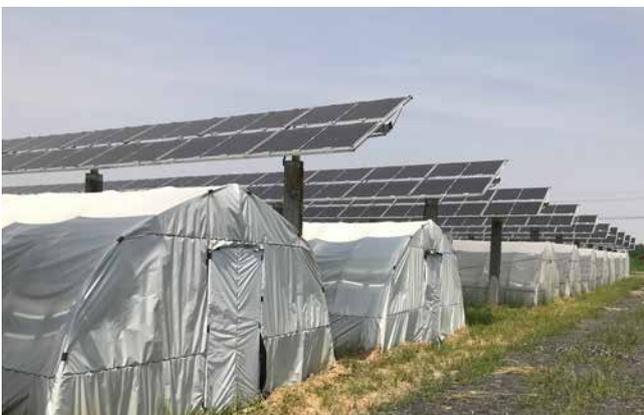
*Bild 37: PV-Module über einem Folientunnel. © BayWa r.e.*
