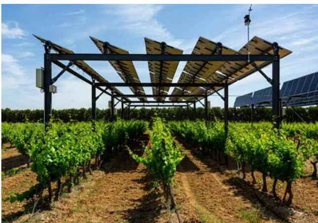
Bild 23: Agri-PV mit nachgeführten Modulen in Frankreich.
