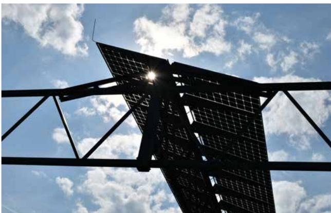
Bild 14: Modulreihe mit bifazialen Modulen der Agri-PV-Anlage in Heggelbach. © Fraunhofer ISE
