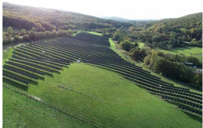
Bild 48: Solarpark Eppelborn-Dirmingen mit 2 MW<sub>p</sub> mit vertikalen Solarzäunen von Next2Sun. © Next2Sun GmbH
