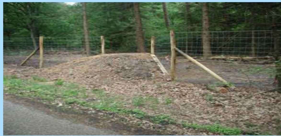
Vb. van toegevoegde afbeelding in het Landschapsplan van een wildhek met schapengaas n.a.v. input
